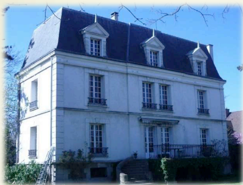
Crédit photo : © Installateur AQUATHERMIE
