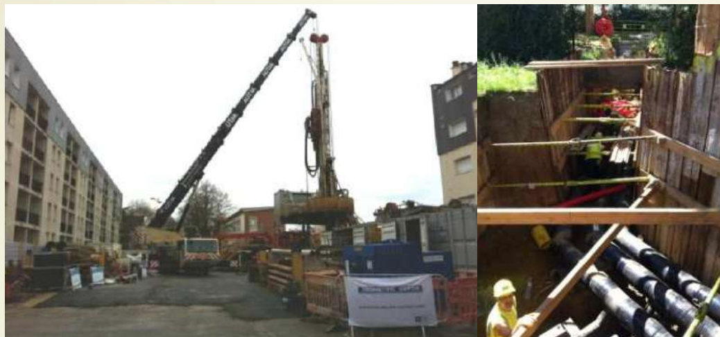
Machine de forage
